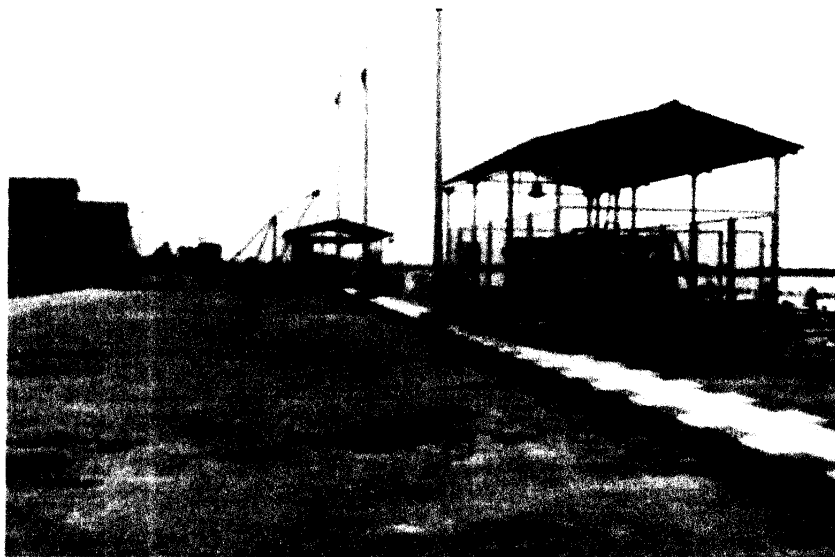
08 CASETA DE MANGUERAS
