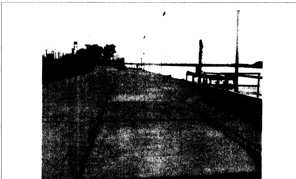
13 PLACA EN CONCRETO MUELLE ANTIGUO
