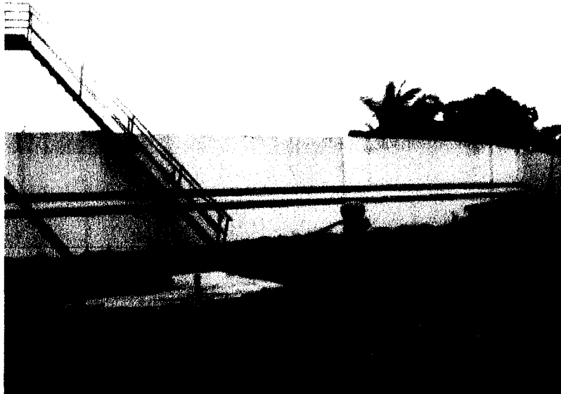
Muro existente sobre el costado sur del área portuaria
